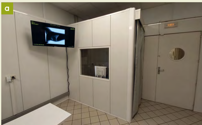
FIGURA 1.32 Cabina con pareti, tetto e finestra in vetro piombato (a) e console di controllo e monitor situati all'interno della cabina (b), dove l'operatore può lavorare senza essere esposto alle radiazioni.
